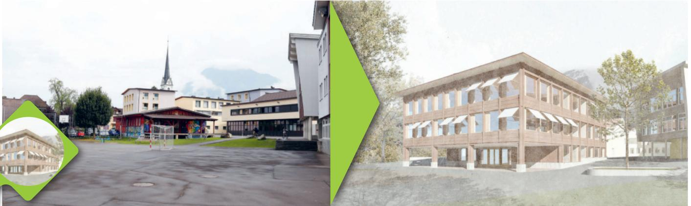
Das neue Primarschulhaus bildet vom Gemeindehaus her einen neuen Zugang zum gesamten Schulareal. Der dreigeschossige Neubau entsteht dort, wo heute der Pavillon WILLA steht. Ab der Foundation in Beton entsteht der Hochbau in Holzbauweise. Dies ermöglicht ein gutes Raumklima und sichert eine kurze Realisierungszeit. Es entstehen 8 zusätzliche Klassenzimmer sowie 4 Gruppenräume. Sie werden durch eine vielseitig nutzbare «Multizone» miteinander verbunden, welche den klassischen Gang ersetzt.
