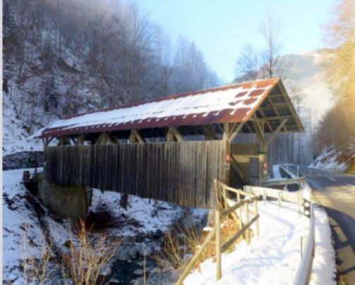
27 m lang führt etwa 1,5 km vor dem Dorf Melchtal über die Melchaa. Die gedeckte Holzbrücke wurde 1943 von der Schweizer Armee in Form eines fast geschlossenen Holzkastens erbaut
