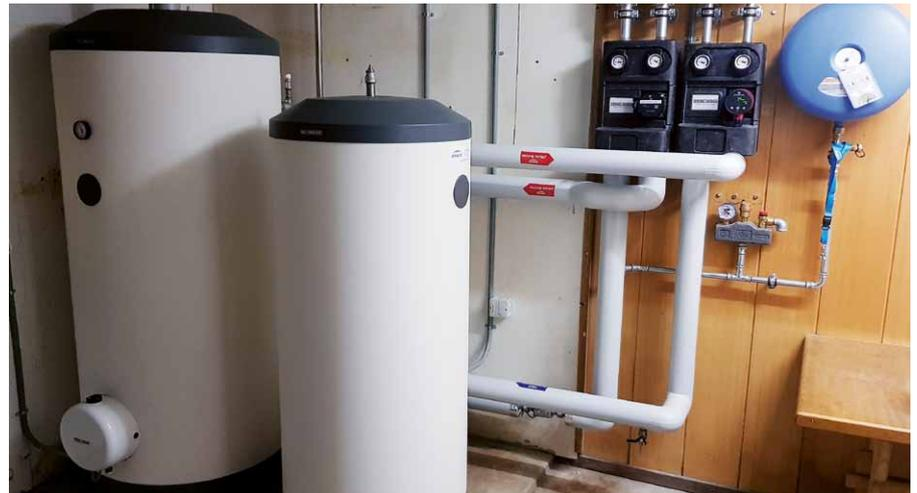
Warmwasser-Speicher (links) und Speicher (rechts) im Keller einer Luft/Wasser-Wärmepumpe.
