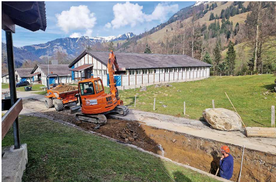
Der Baustart zum Wasserversorgungsprojekt Melchtal und Kleinkraftwerk Turrenbach ist erfolgt.
