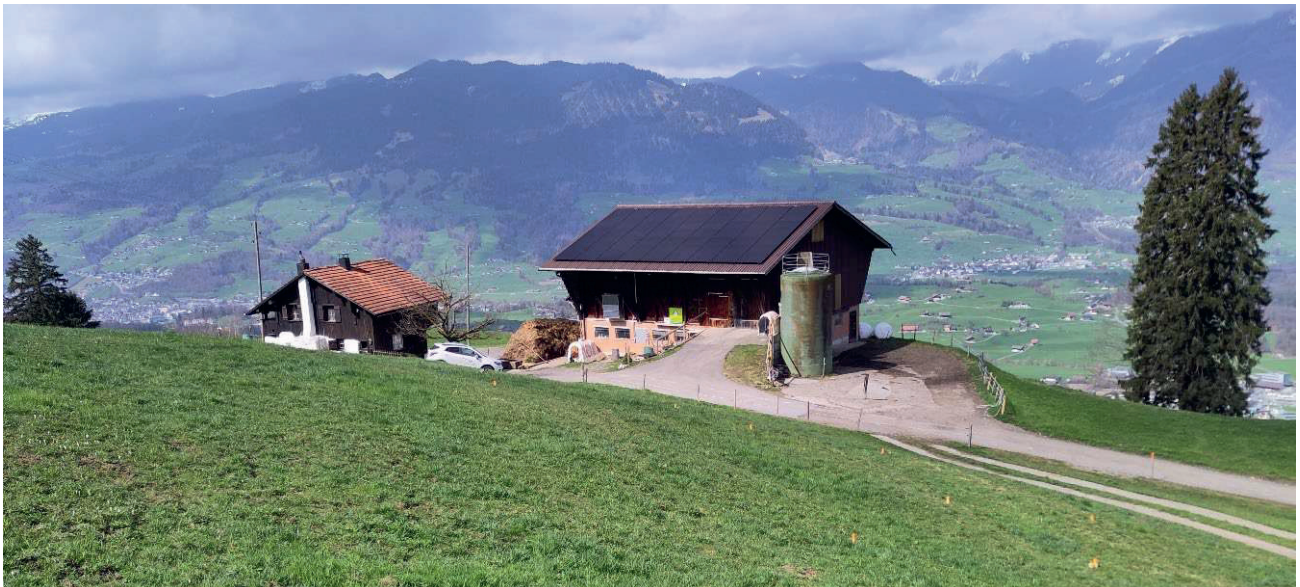
Standort des geplanten neuen Reservoirs oberhalb der Liegenschaft Heumattli
