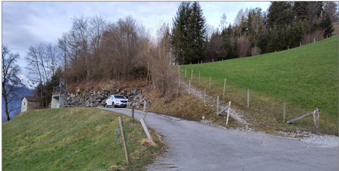
Abbildung 17: Reservoir Steini, Blick ab der Steinistrasse.
