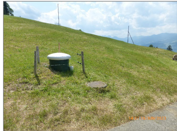
Abbildung 4: Brunnenstube 1996, daneben Überlauf- und Entleerungsschacht.
