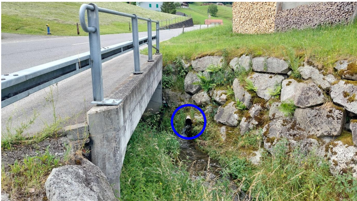
Foto 10: Auslauf Eindolung (PE-Rohr, dm = 0.25 m) unterhalb Brücke Melchtalerstrasse (blauer Kreis) mit Mündung in den Türligraben (oeko-b ag, 15.06.2026).
