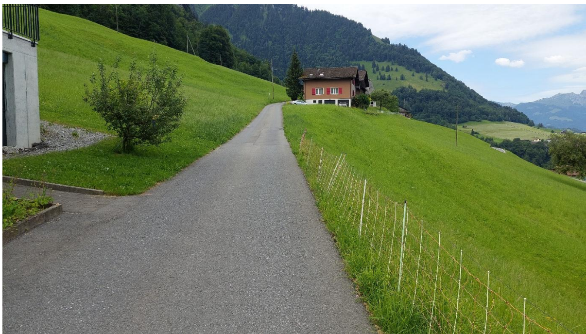
Foto 1: Einzugsgebiet Gräbli Untergass im Bereich der Schildstrasse, aus welcher Meteorwasser in das Gräbli Untergass eingeleitet wird (oeko-b ag, 15.06.2026).
