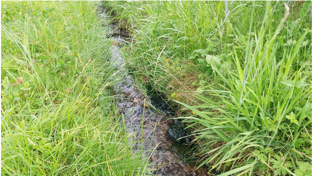
Foto 5: Offener, unverbauter Abschnitt Untergass mit Sohlenbreite 0.2 – 0.4 m, Blick in Fliessrichtung (oeke-b ag, 15.06.2026).
