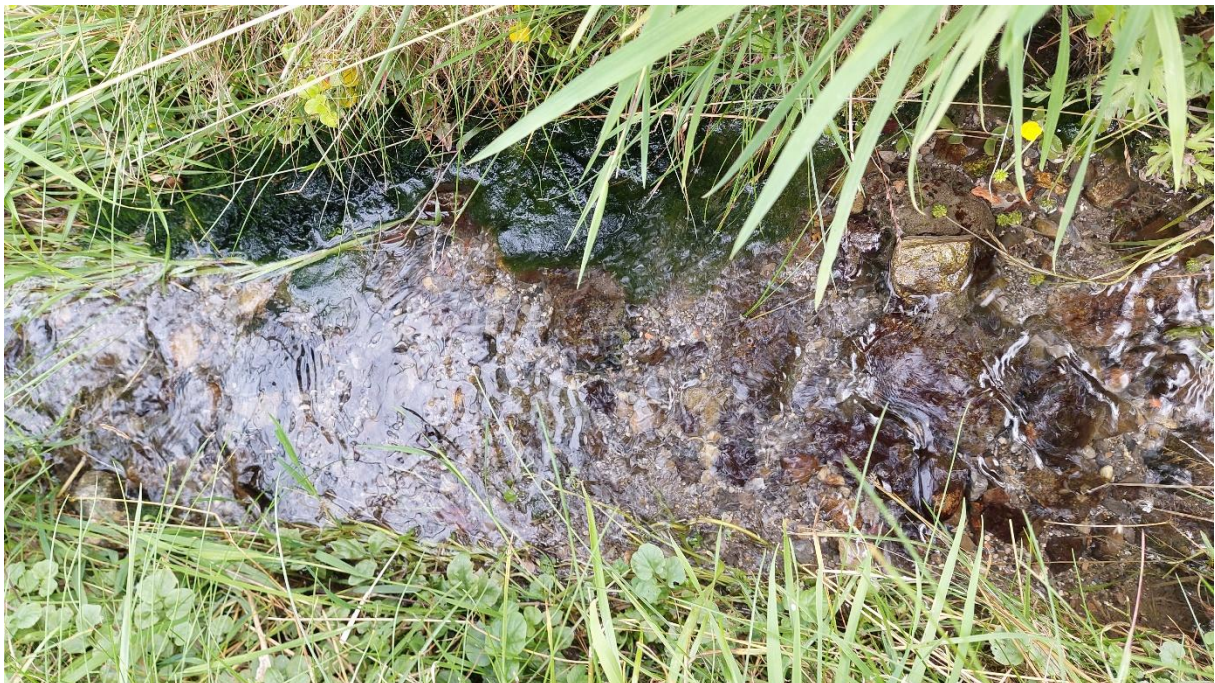
Foto 6: Offener, unverbauter Abschnitt Untergass mit Sohlenbreite 0.2 – 0.4 m (oeke-b ag, 15.06.2026).
