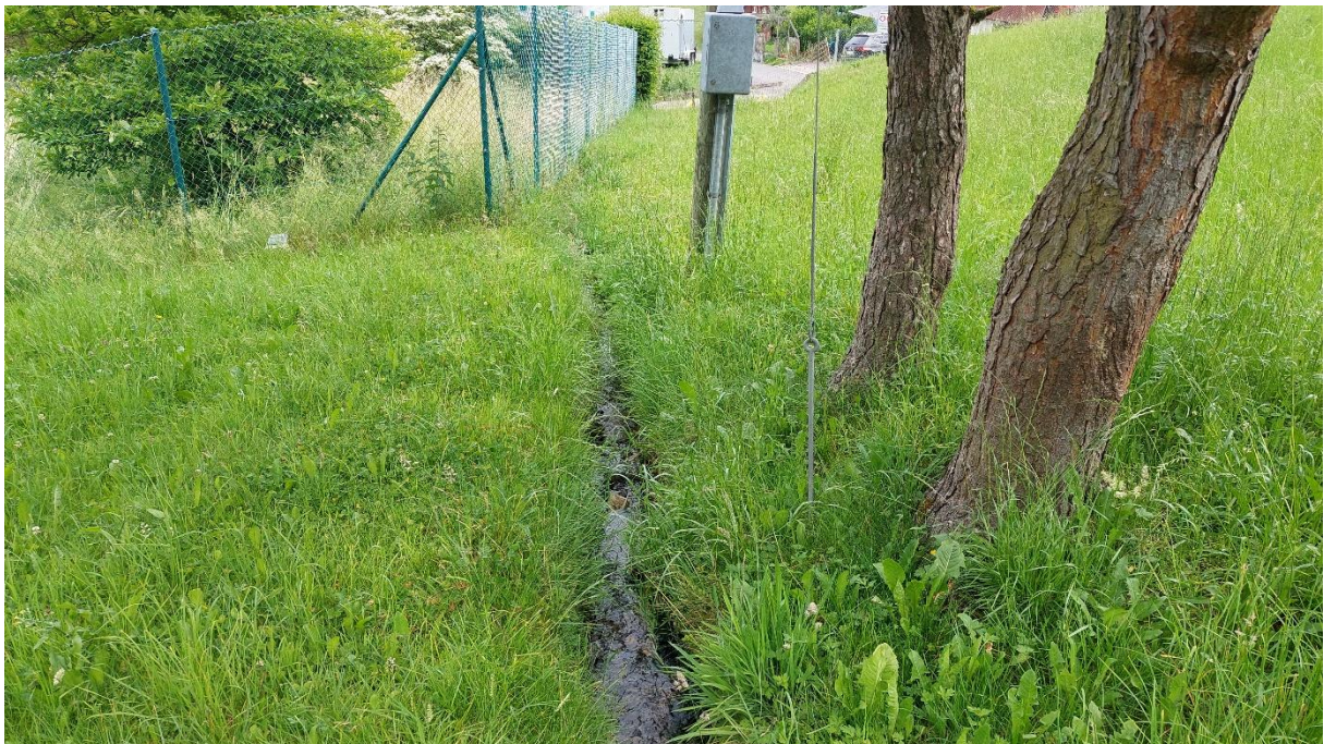
Foto 4: Offener, unverbauter Abschnitt Untergass mit Sohlenbreite 0.2 – 0.4 m, Blick in Fliessrichtung (oeko-b ag, 15.06.2026).
