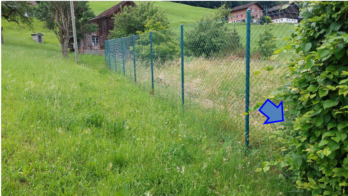
Foto 9: Offener, unverbauter Abschnitt Untergass hinter Zaun im Bereich Parzelle 793 (GB Kerns) mit Einlauf in Eindolung Zubenstrasse (blauer Pfeil), Blick gegen Fließrichtung (oeko-b ag, 15.06.2026).
